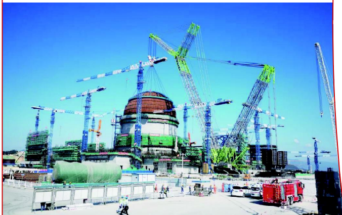
漳州核电1号机组内穹顶成功吊装
