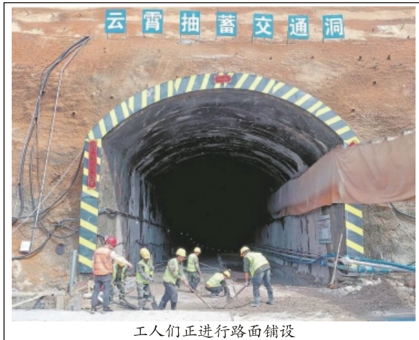
工人们正进行路面铺设
