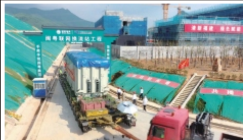
运输车组抵达工程现场
