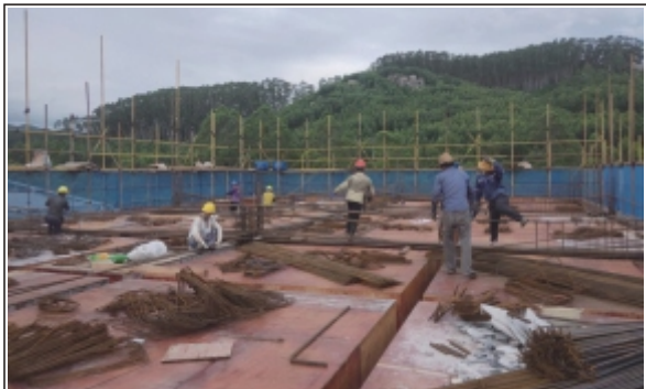
云霄海润新材料生产项目施工现场
