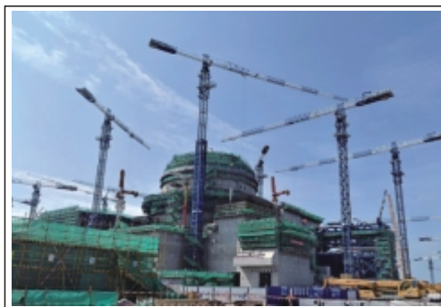
漳州核电项目建设现场 央广网记者：罗晓英摄
