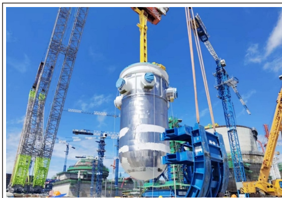
漳州核电2号机组压力容器吊装就位
