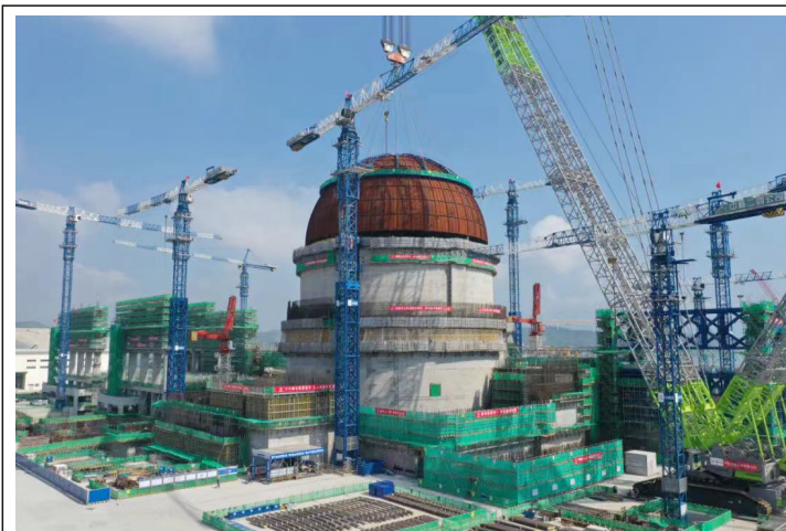
福建云霄抽水蓄能电站主体工程开工
