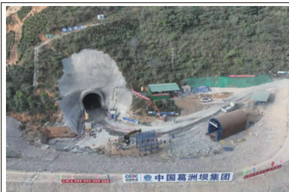
福建云霄抽水蓄能电站项目
