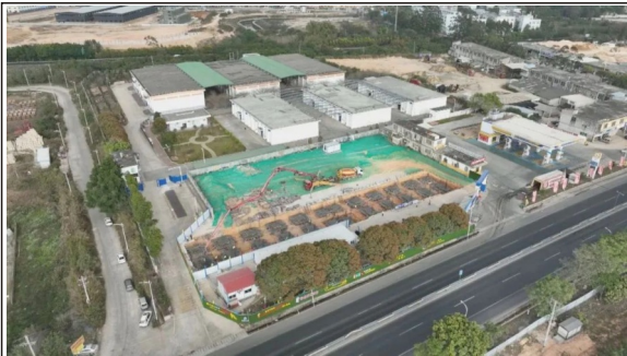
粮食仓储改扩建和物流中心项目施工现场
