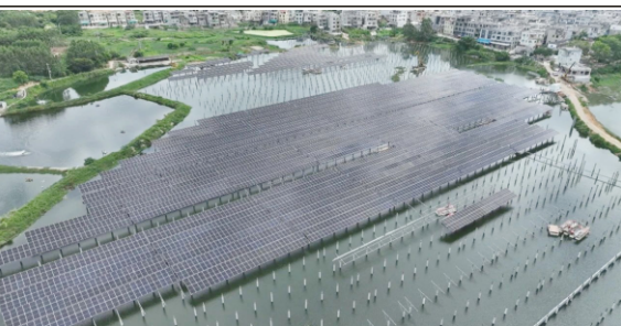
中核云霄陈岱渔光互补项目岱山片区
