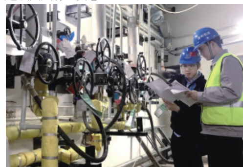
春节期间，核电建设者坚守岗位，严密做好设备调试工作。
