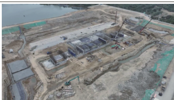
北江水闸提升改造工程
