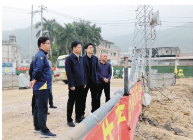
蓝良木一行赴北江水闸提升改造工程现场办公解难题
