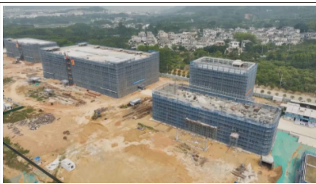
福建豪锦生物科技标准化厂房建设项目现场
