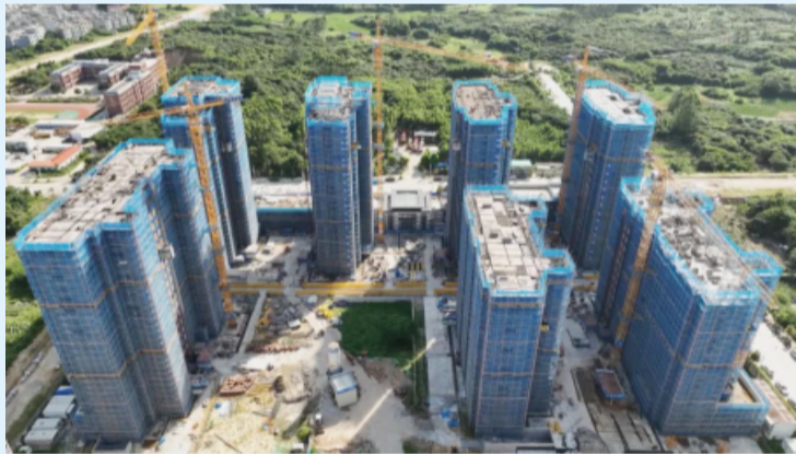
云霄县陈岱镇岱北安置房项目建设现场
