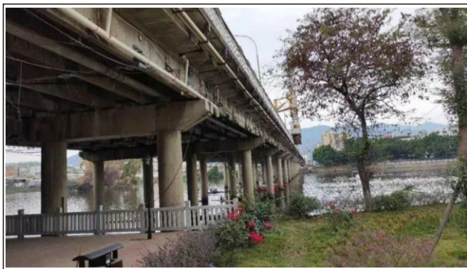
新建云霄大桥设计总长360米、宽33米
