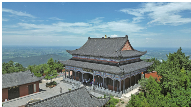
位于河南省固始县安阳山的大山奶奶庙，是为纪念陈元光祖母魏敬所建的。 李林 摄
