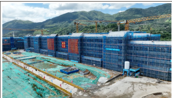
云霄一中新校区迁建项目施工现场
