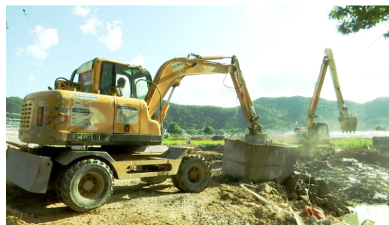
挖掘机大铲挥舞，施工作业
