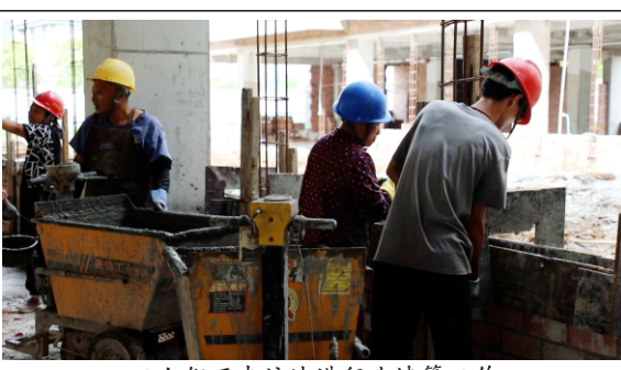
工人们正专注地进行砌墙等工作
