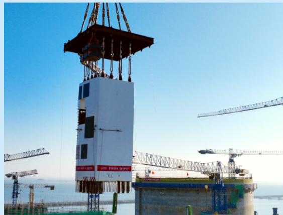
模块构件吊装就位
