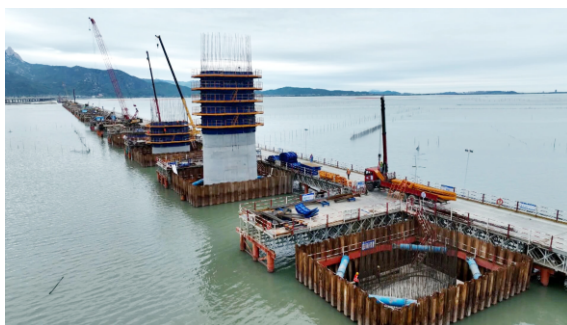
各类施工机械轰鸣作响，建设如火如荼
