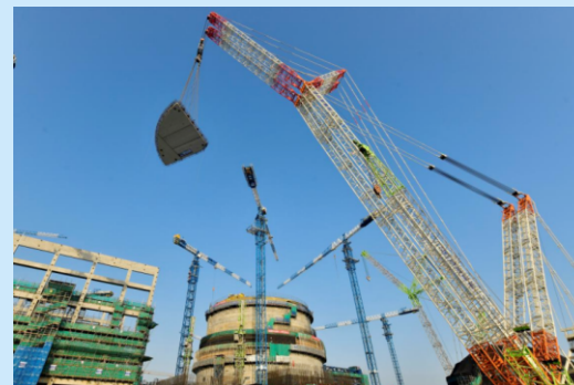
漳州核电3号机组核岛内部结构钢混一体模块吊装成功
