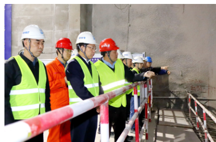
蓝良木实地察看主厂房、主变动以及下库进出水口等关键节点施工进度
