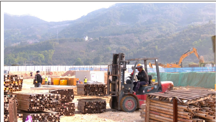
云霄一中新校区迁建项目施工现场
