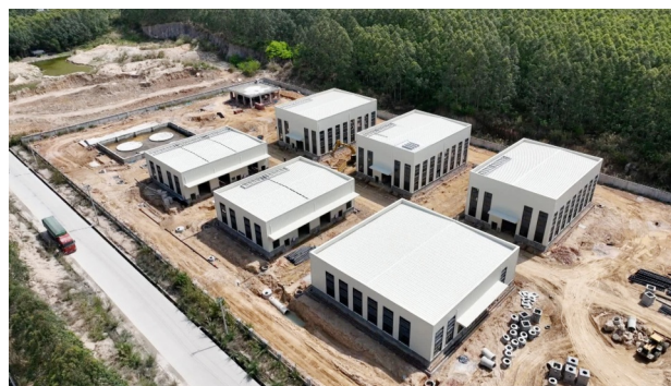
富企科技项目建设现场
