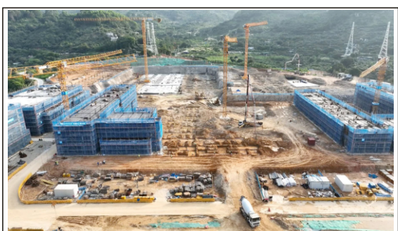
云霄一中新校区迁建项目建设现场
