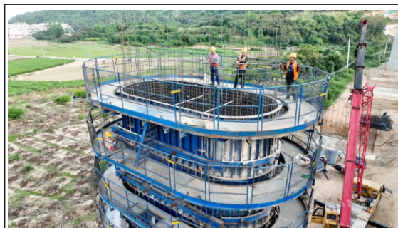
漳汕高铁青径特大桥建设现场
