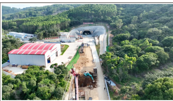
林坪隧道施工现场
