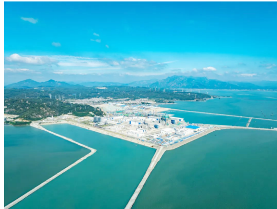
俯瞰漳州核电项目。方伟文摄
