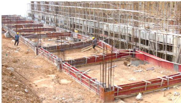
中央蛋库、管理用房及检验检疫中心的主体施工中
