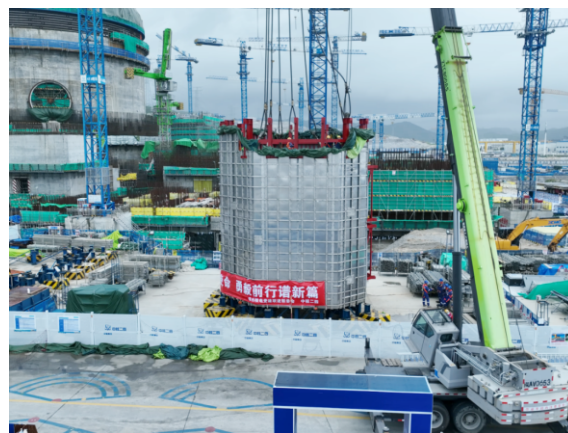
漳州核电3号机组核岛反应堆厂房堆腔换料水池模块吊装成功
