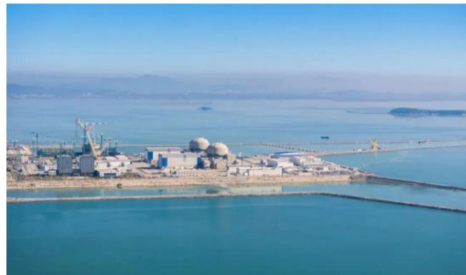
记录”，“开顶法”施工、主设备先行引入、不锈钢覆面先贴法施工等工法不断创新，不但大幅提升了施工效率，还有效减少了高风险作业。
