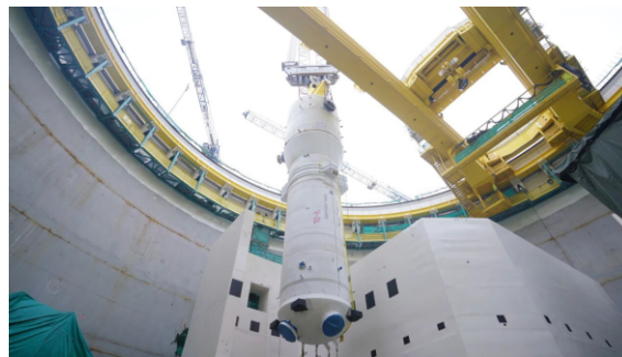
漳州核电3号机组蒸汽发生器全部吊装就位
