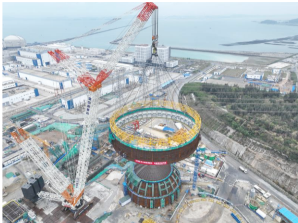
漳州核电4号机组反应堆厂房钢衬里模块六吊装就位
