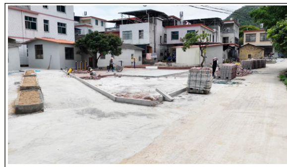
工人为新建的小公园铺砖中
