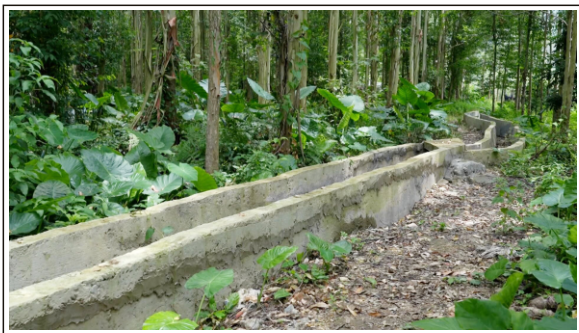
白楼自然村修建的660米排水沟渠
