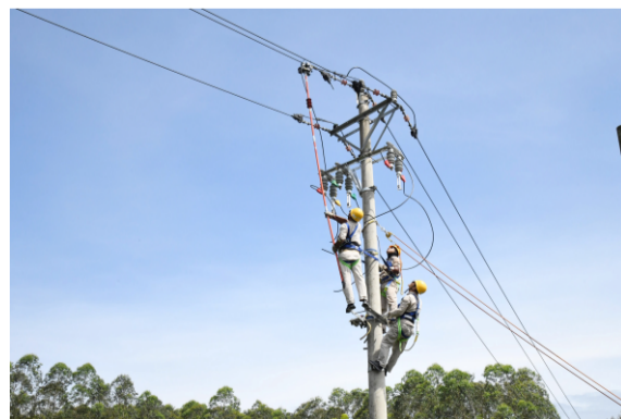
带电作业人员采用地电位作业方式加装隔离刀闸
