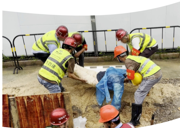
抢险救援组在技术指导下清理土方、搜救被困人员
