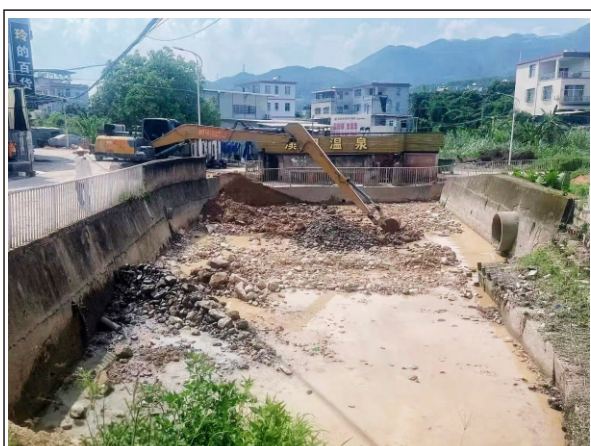
溪口村黑臭塘体正进行清淤疏浚
