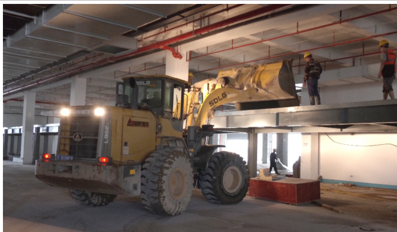
厂房内部施工现场
