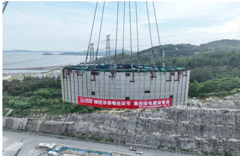
模块三平稳就位非能动堆腔注水箱模块二上
