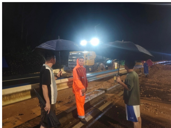
火田镇组织驻村工作队、古楼村“两委”干部赶赴现场开展抢险作业
